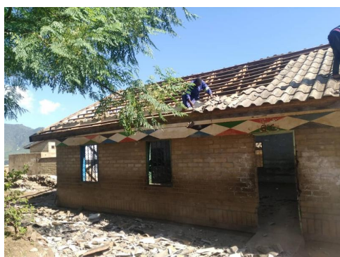
Reparatur des Daches an der Namilango Primary School Urheber: Blantyre City Council
